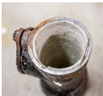
▲ Rør som er rensed og har fått et nytt lag med glassarmert polyester. Gamlerøret blir en forskaling.
